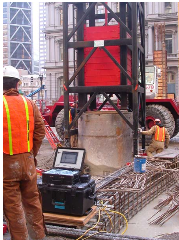
Bild 5: Dynamische Probelastung von Grossbohrpfahl mit 36 Tonnen APPLE
