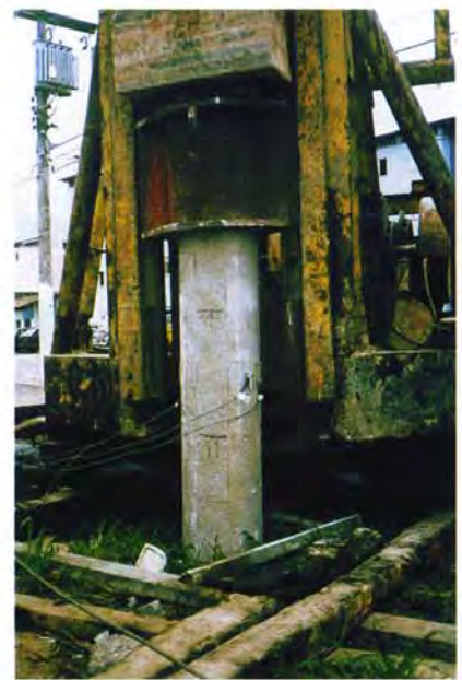
O ensaio de carregamento dinâmico aplica-se tanto a estacas pré-moldadas como estacas moldadas in loco . A repercussão das ondas após a batida com o martelo mostra a integridade da estaca e a interação com o solo
