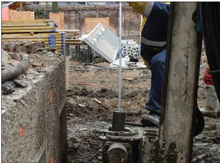
Установка кабеля THERMAL WIRE в отлитую колонну
