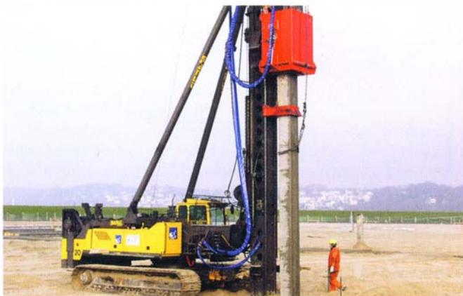
**Bild 1.** Einbringen eines Centrum-Pfahls für die Gründung der Lackierhalle
