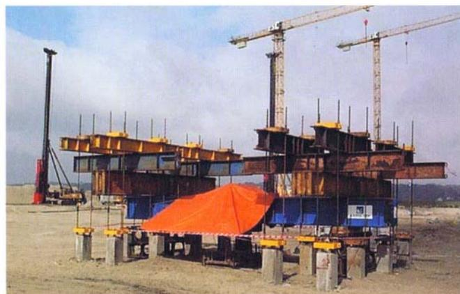
**Bild 2.** 1200 dieser Centrum-Pfähle gewährleisten die sichere Gründung der Halle
