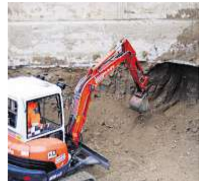
Die Pfähle werden freigelegt.
