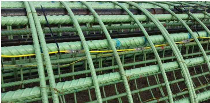
Dây kèm các đầu đo nhiệt được gắn cùng với lồng thép
