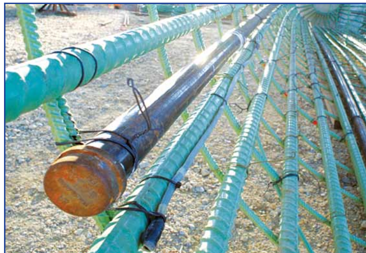
Thermal Wire® закреплен на арматуре совместно с закладным каналом.
