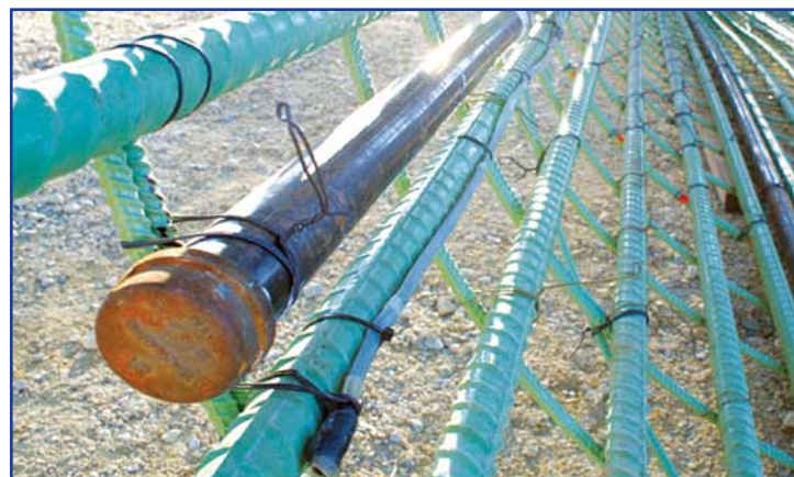
Fiação THERMAL WIRE acoplada à armadura (aparecem também tubos de acesso)
