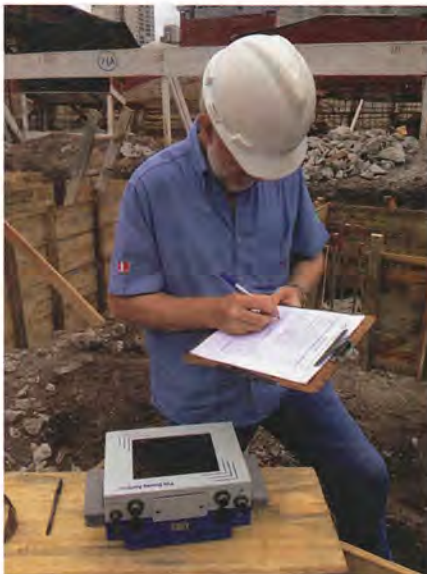
Geo Estac y PDI Engenharia utilizaron el Pile Driving Analyzer para ensayos de obras de un edificio residencial en Sao Paulo.
