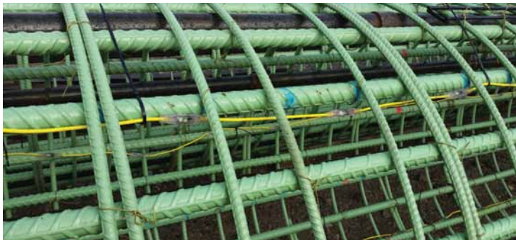
Cable marca Thermal Wire® (Alambre Térmico) pegado a el armado
