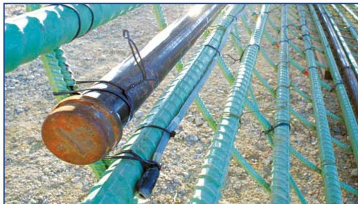
Cavo termico collegato alla gabbia di armatura ed in prossimità del tubo di ispezione.
